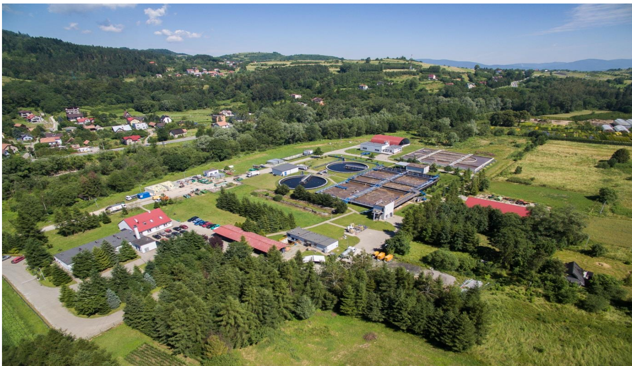
Oczyszczalnia ścieków w Cięcinie
